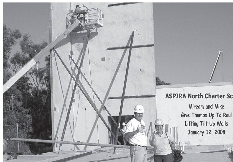
Mike Balais, contratista general, y la ex-Presidenta de la junta ASPIRA Miream Sierra, durante el levantamiento de las primeras paredes de Charter North.
